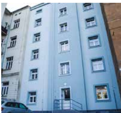
Zrekonstruovaný dům v Plachého ulici číslo 42. Foto: Martin Pecuch
